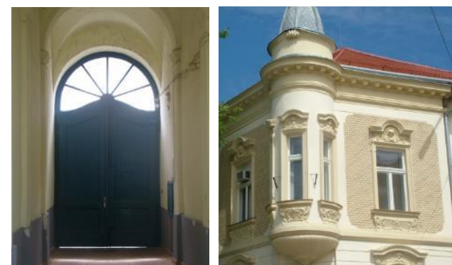
Nagykőrösi u. 11. épületrészletei
