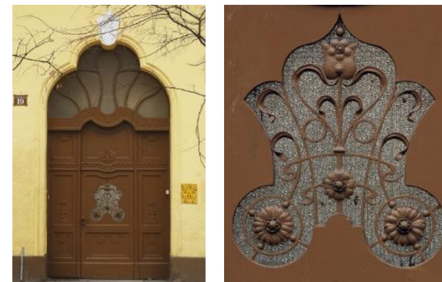
Nagykőrösi u. 19. épületrészletei
