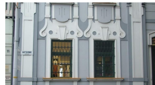
Batthyány u. 9. nyílászárói és homlokzat részlete
