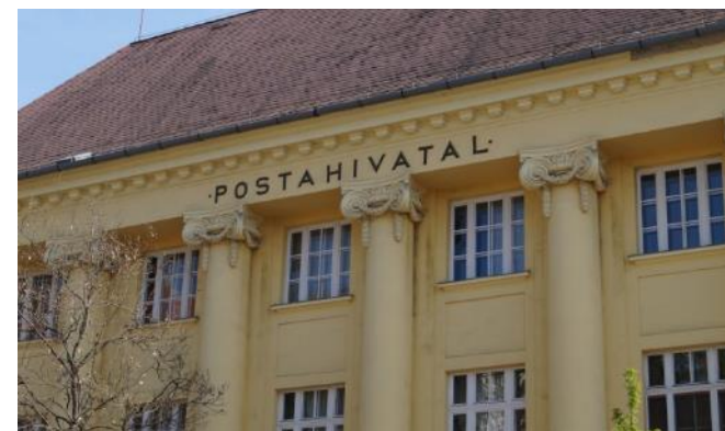
Kálvin tér 10. épületrészlet
