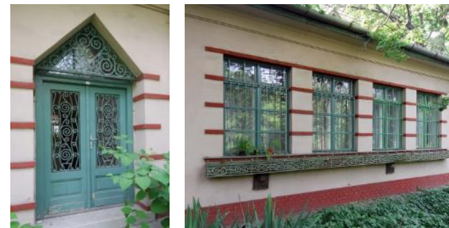
Ceglédi út 2. nyílászáró díszrácsozata
