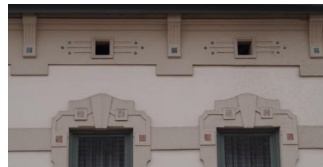
Kada Elek u. 20. épületrészlet
