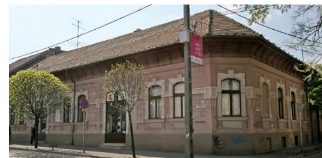
Kápolna u. 22. homlokzata
