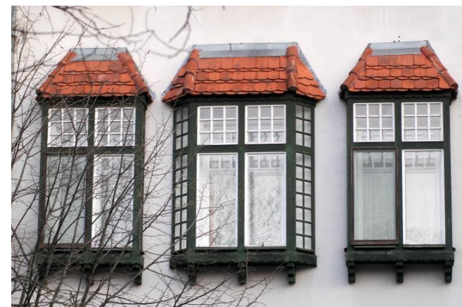
Rákóczi u. 5. nyílászárói
