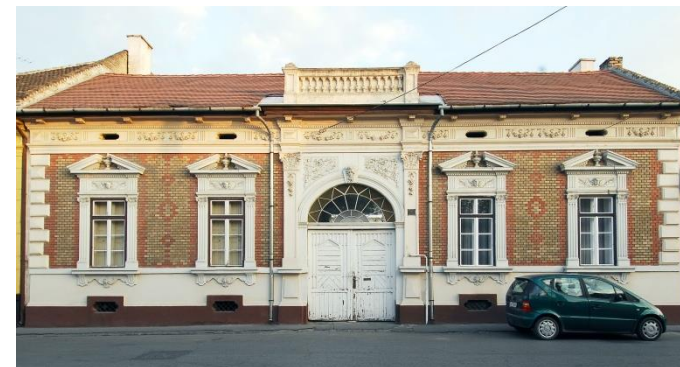
Losonczy u. 5. főhomlokzata
