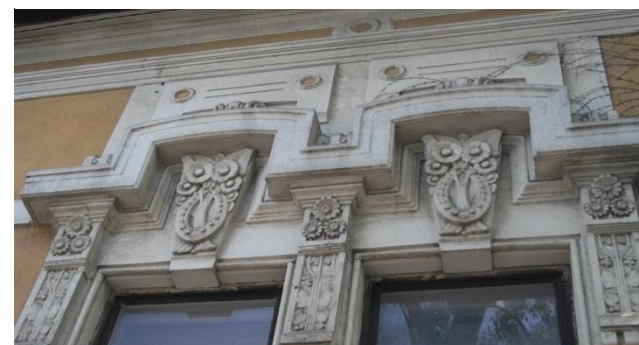
Csongrádi u. 32. homlokzati díszítése
