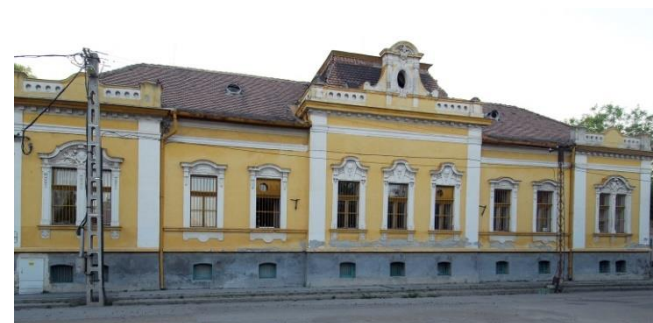
Ótemető u. 2. főhomlokzata
