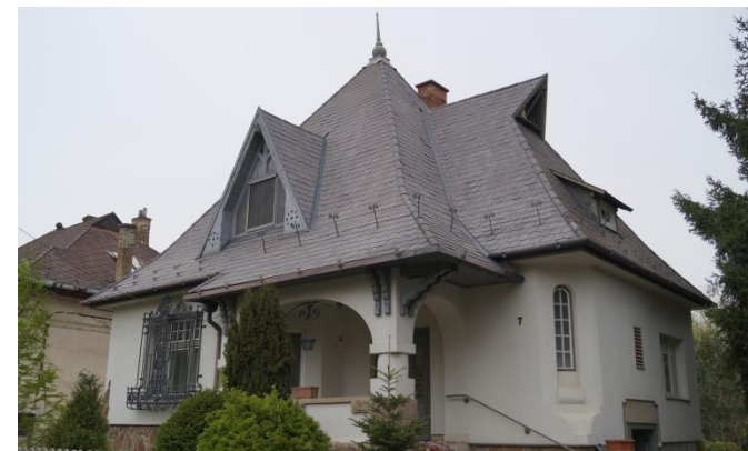
Teleki L. u. 7. épülettömege
