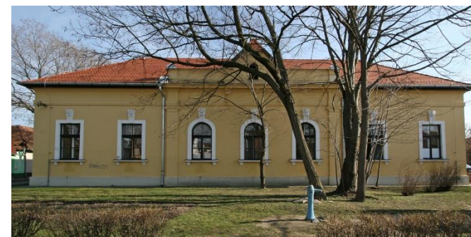
Szalag u. 9. főhomlokzata
