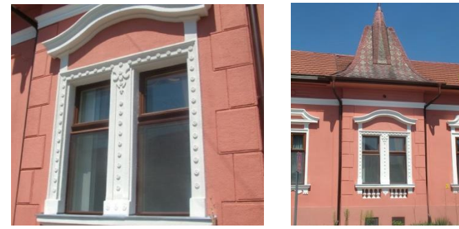
Kaszap u. 4. nyílászárója és díszítése
