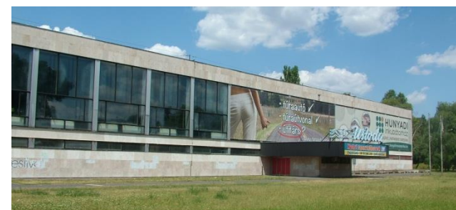
Izsáki út 1. homlokzata
