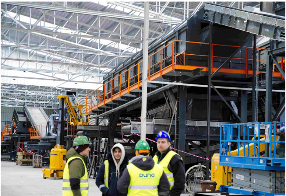
A vegyesen gyűjtött száraz hulladékokból még hasznosítható hulladék kezelése valósul meg Kiszáiban
