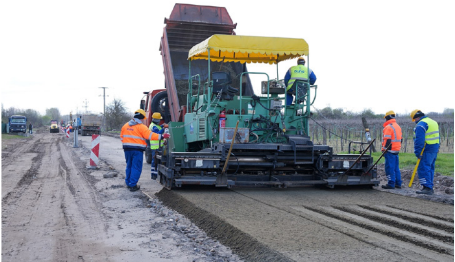
A hulladéklerakóig a pályázat biztosította két réteg aszfaltburkolat felvitelét
