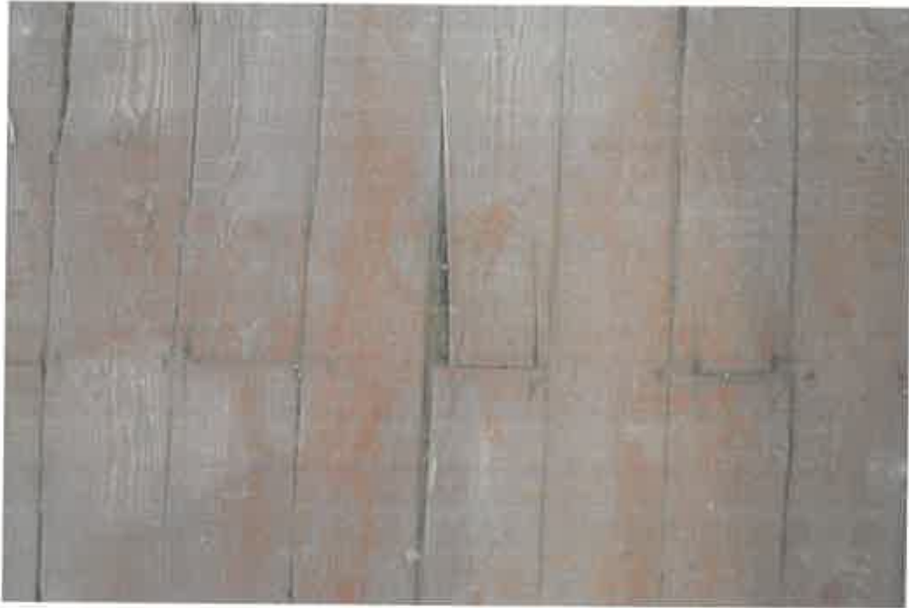
A deszkák helyenként hiányosak és töröttek.
