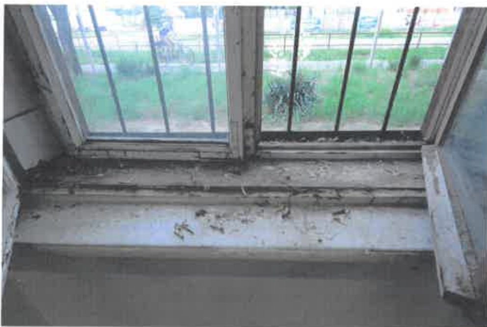
A rács rozsdás, az ablakokról a festékréteg hiányzó.
