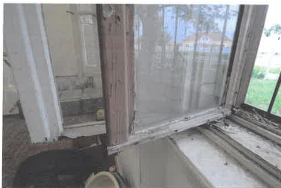
Az üvegezés ép, azonban a gitt több helyen hiányzik.
