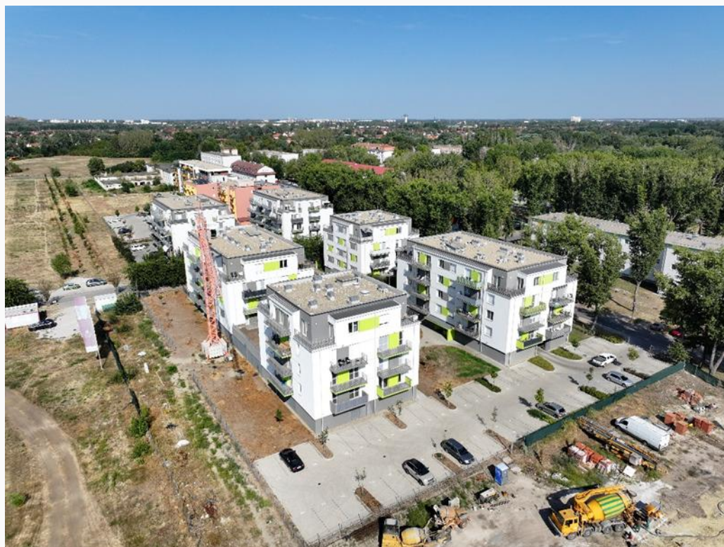
8. ábra: Építkezés Homokbányán.
