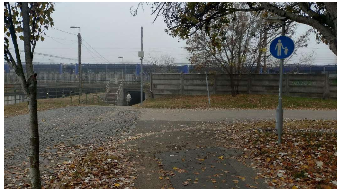
30. ábra: A Szolnoki úti aluljáró keleti bejárata
